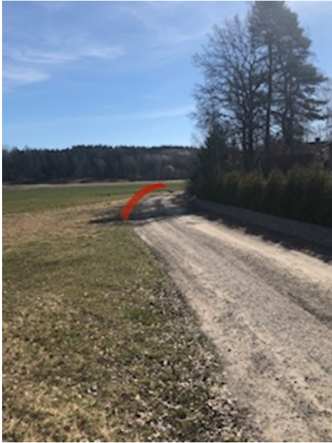
Åkerkanstsvägen 18-22, vänster sida, rensa dike och kantskär.
