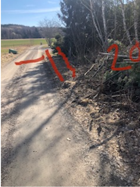
Åkerkanstsvägen 20, höger sida, skapa stendike och kantskär vägen, dra en ledning genom vägen till vänstra diket
