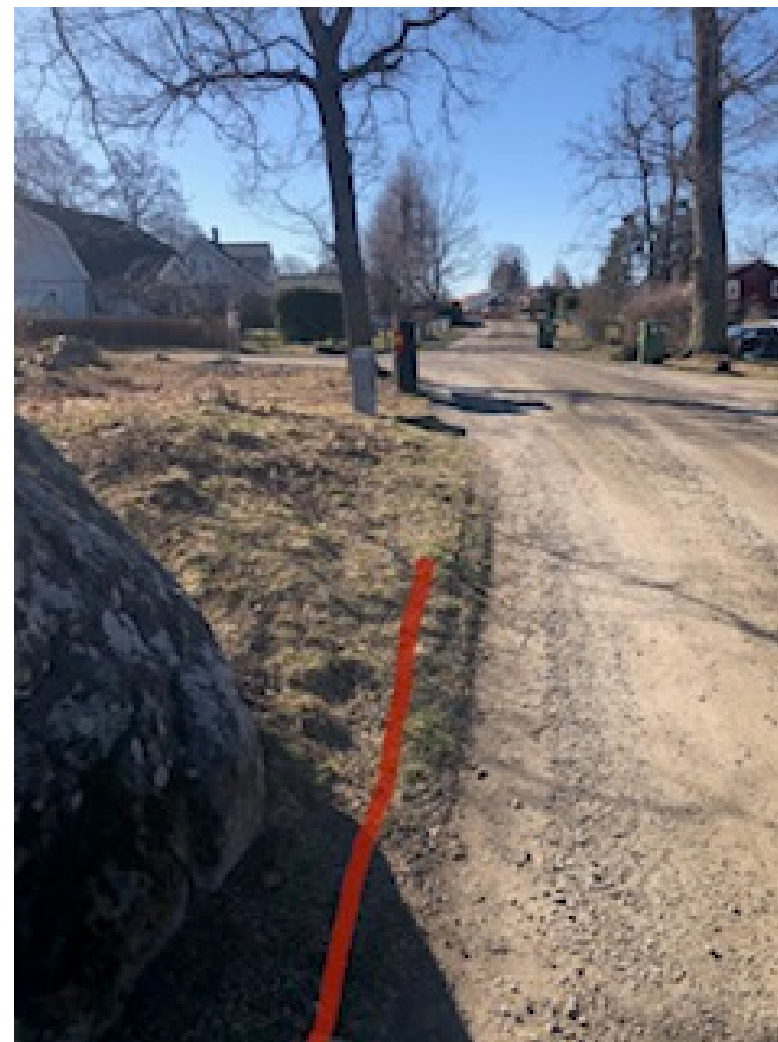
Kristin Ribbingsväg 17-27, vänster sida, Skapa ett stenfyllt dike som börjar eller går igenom infart till 17 och slutar innan elskåpen i korsningen med Åkerkantsvägen. För att undvika att man leder vatten ända ned till 17 så kan man börja med att skapa ett stenfyllt dike mellan varje infart och sätta en perkolationsbrunn i lågpunkten,
