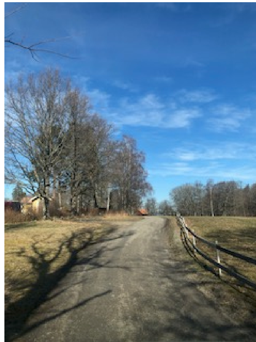
Bollplansvägen 6-10, lite slitlager bör kompletteras
