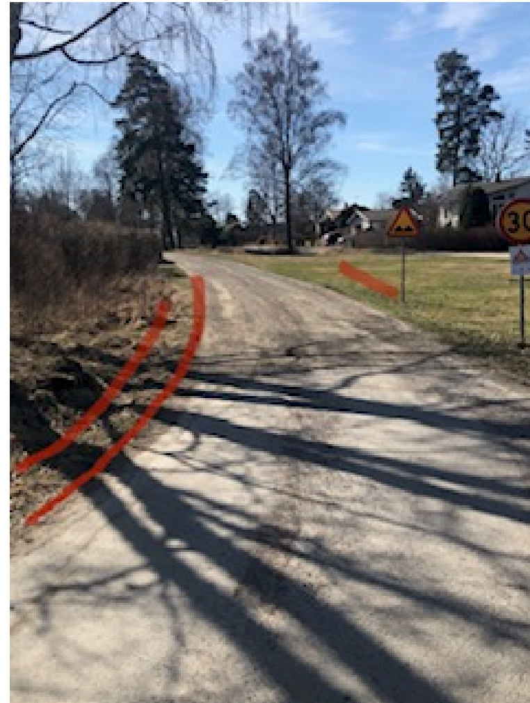
Stallviksvägen 1, höger och vänstersida, kantskär vägen, skapa svackdike på vänster sida mellan anslutning av Campingvägen till infart vid Stallviksvägen 1
